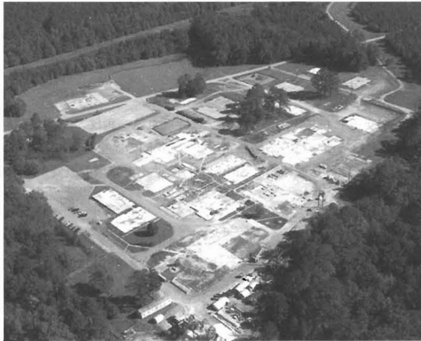
写真2 サバナナリバー廃止措置の変遷 (2004年11月 建屋の解体完了時)
