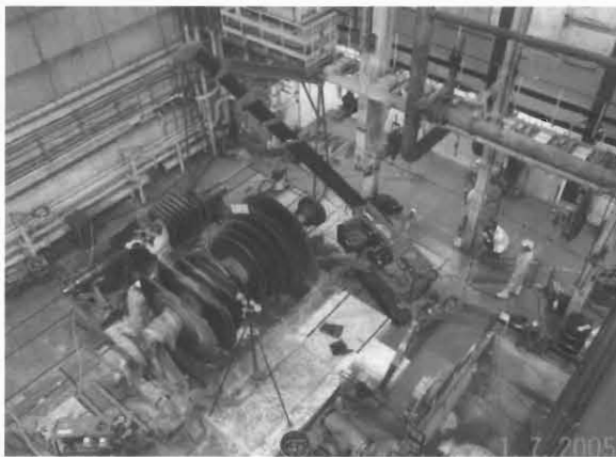
写真1 蒸気タービンロータの解体
