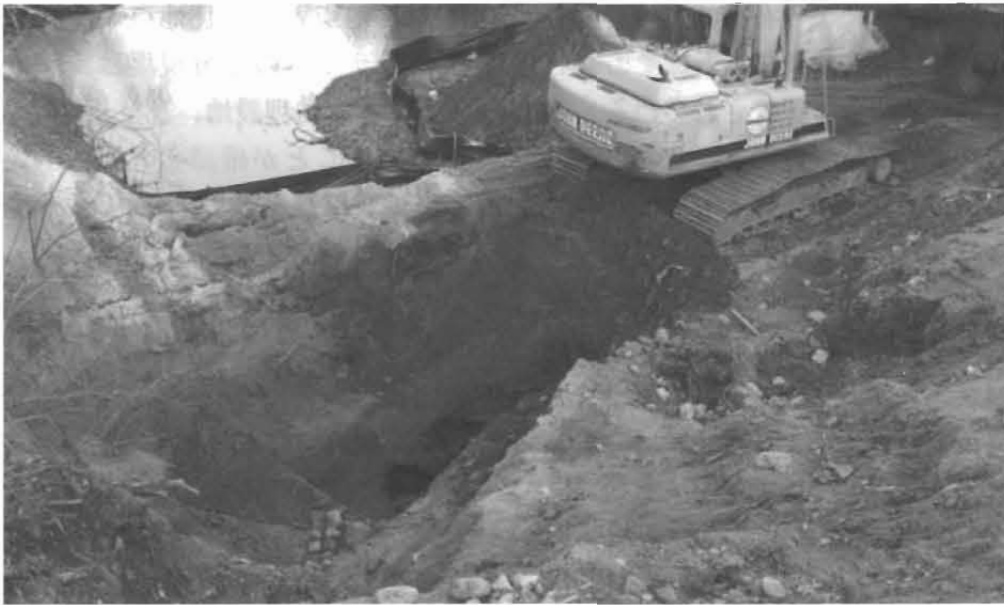
図2 ドラム缶埋設地の掘削状況
