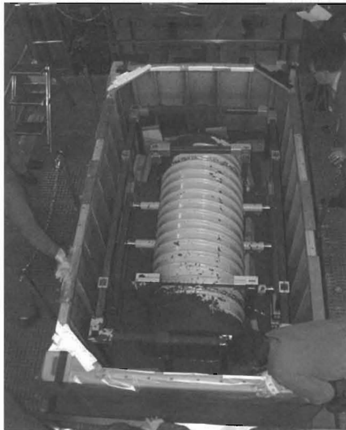
図2 Konrad処分場用コンテナに定置されたペレット焼結炉＜同上＞
