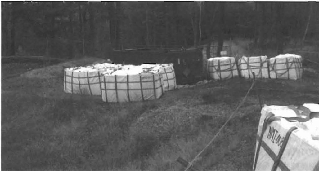
図3 保管用コンテナと埋設処分用補強袋
