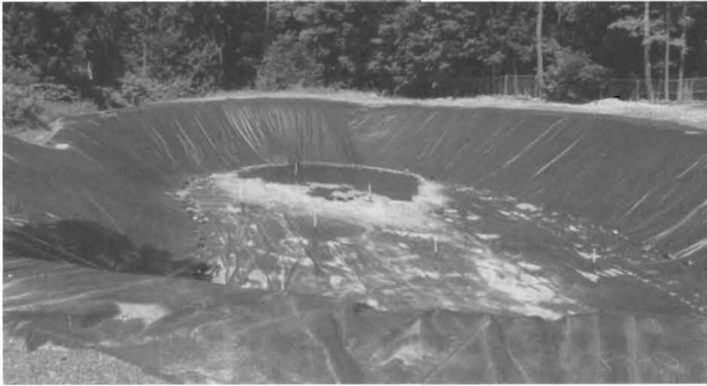
図1 地質ボーリング地点（汚染拡散防止ピット内）
