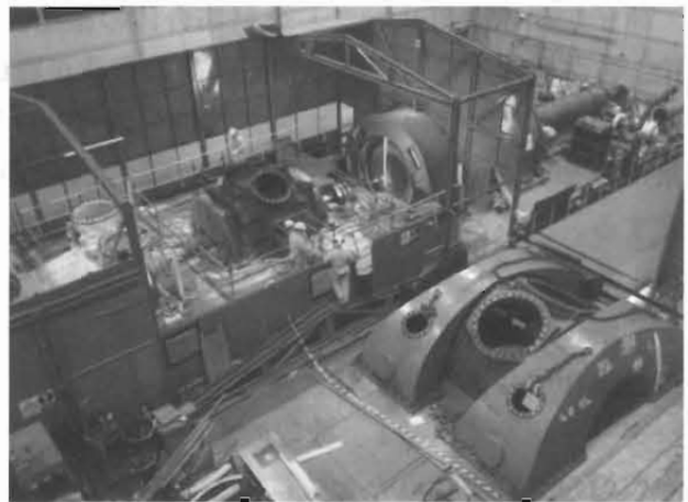
写真2 蒸気タービン及び交流発電機の解体
