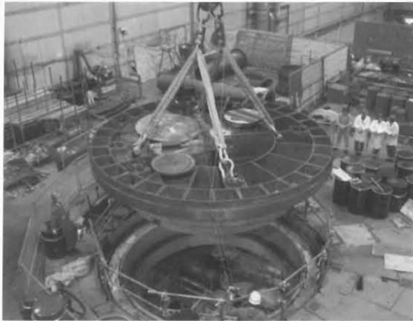
写真3 燃料交換遮へい体の解体
